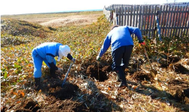
植栽地での穴掘り作業（令和元年 10 月）
