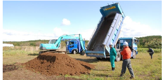
苗畑造成のため保育所裏に搬入される畑土(H20年9月)
