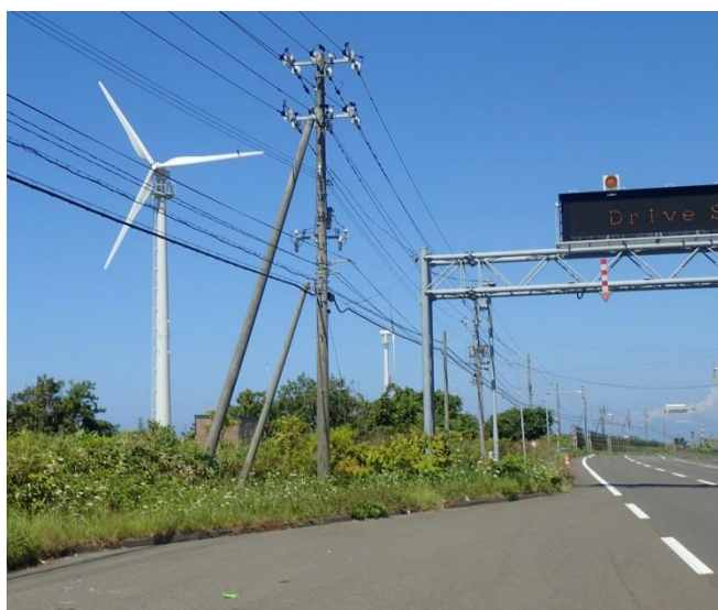
羽幌町の駐車帯の近くに建設された中型風車
