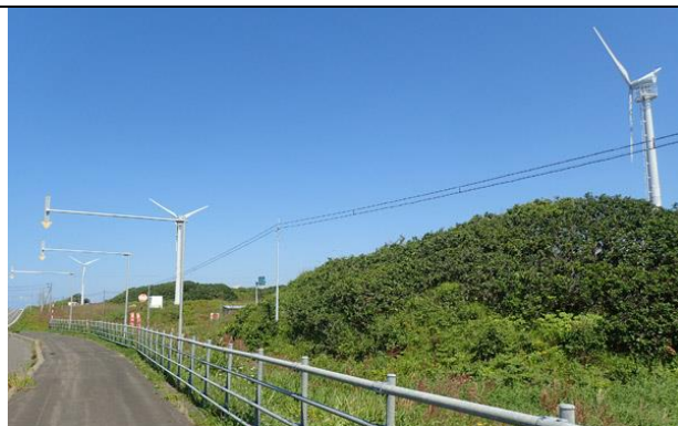
初山別村の国道沿いに建設された中型風車
