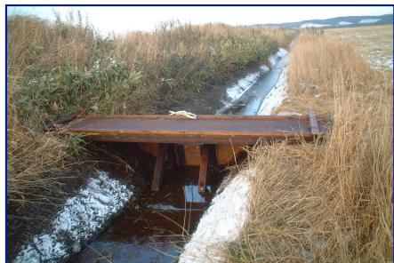
左の写真は、平成15年11月から上サロベツの公共草地において排水調整堰を設置し、その操作性等の維持管理に係る実証試験を行っている状況写真です。排水調整堰の設置による泥炭農地の沈下効果については、調査結果がまとまり次第、本通信等を活用してお知らせします。
