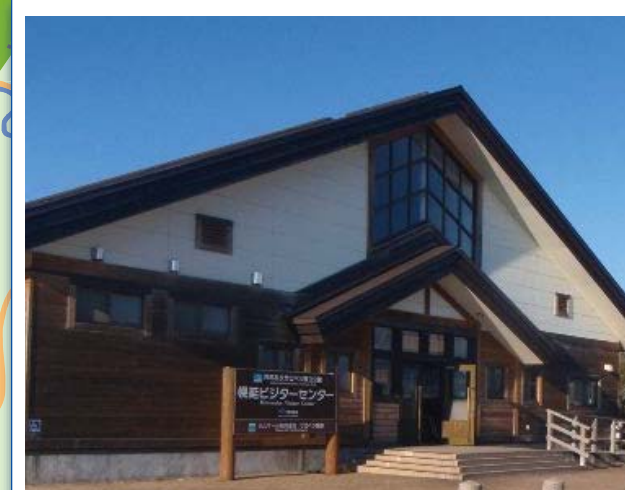
幌延ビジターセンター 沼が間近にあるため、水鳥と植物の観察ができます。木道はパンケ沼まで続きます。
