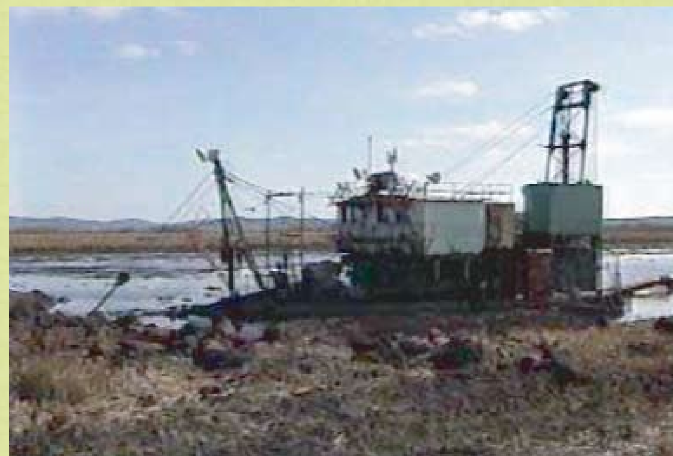
＊浚渫船による採掘作業の様子
